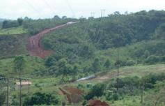
**PREPARANDO O TERRENO:** a primeira etapa envolve a limpeza da área com retirada de vegetação, nivelamento e criação de acessos para maquinaria e equipes de construção.
