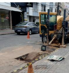
**OBRAS NA ÁREA URBANA:** quando for necessário realizar abertura de valas em áreas urbanas, o fechamento do corte do asfalto acontece em até 3 dias úteis. Geralmente é feita a colocação de uma chapa de aço ou a reconstituição provisória do asfalto. O objetivo é reestabelecer o fluxo normal de trânsito no local. Não se preocupe com a qualidade do asfalto nesse momento, pois ele não será definitivo.
