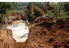
**ABERTURA DE VALAS:** escavações são feitas ao longo da rota do gasoduto para abrir o espaço necessário para a colocação dos tubos. Essa etapa é importante para garantir a profundidade adequada e segura.
