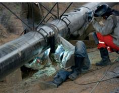
**SOLDAGEM E MONTAGEM DOS TUBOS:** os tubos são desfilados e soldados ao lado das valas. A soldagem é feita com precisão para garantir a integridade da estrutura do gasoduto.
