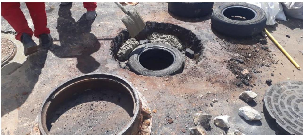
Figura 32 - Concretagem da base utilizando pneu como forma. Fonte: Elaboração própria.
