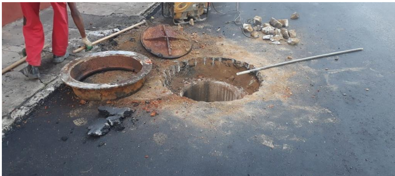
Figura 31 - Retirada do aro e tampa do poço de visita para alteamento. Fonte: Elaboração própria.
