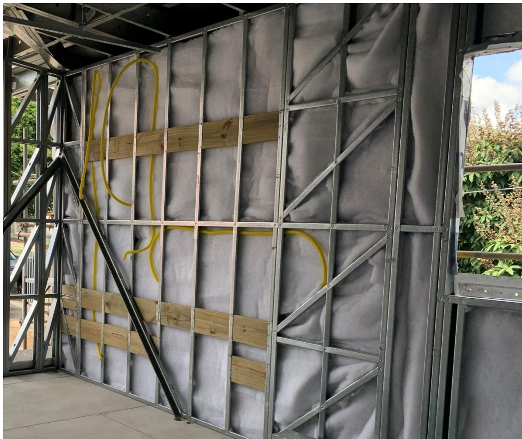
Figura 28 - Lã de PET instalada em estrutura LSF. Fonte: Acervo próprio (2022).
