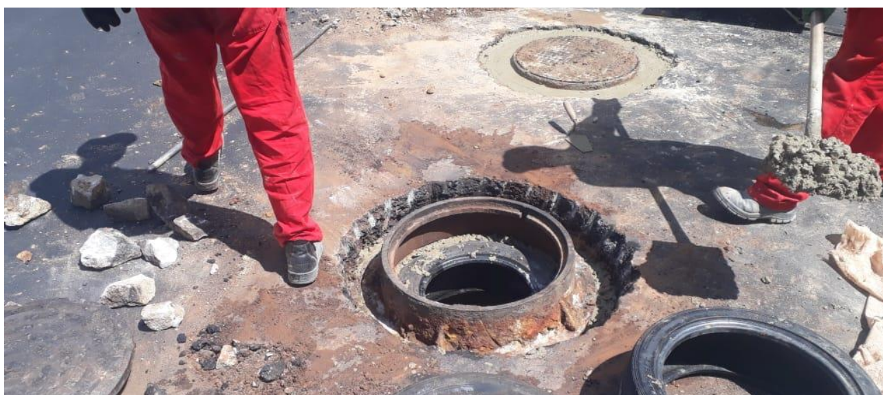
Figura 33 - Chumbamento do aro do poço de visita com concreto. Ao fundo, outro poço de visita assentado. Fonte: Elaboração própria.
